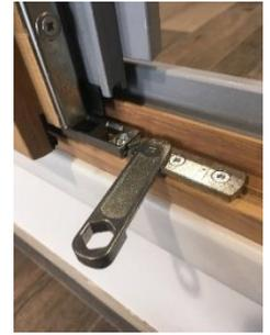
Pour les menuiseries à fermeture mouton et gueule de loup, graisser tout le long de la fermeture avec un lubrifiant
